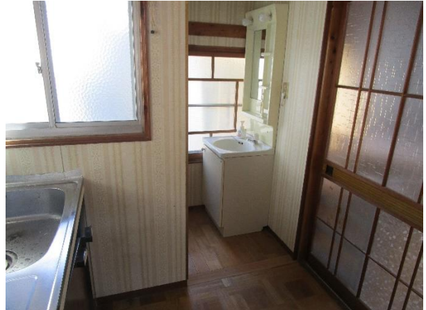
1階 洗面台（別棟）
